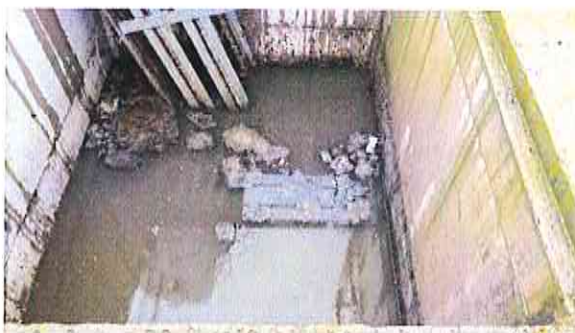
Imagen 3. Reja de gruesos anegada el 16/12/2016. Fuente: Elaboración propia
